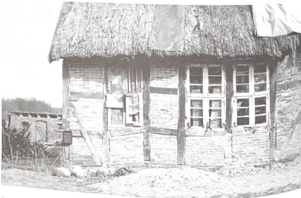
gerichtet waren, konnte im Oktober 1995 auch die zweite Hälfte des Daches wieder mit Rohr gedeckt werden. Im Sommer des Jahres 1996 wird mit der Lehmausfachung begonnen.
